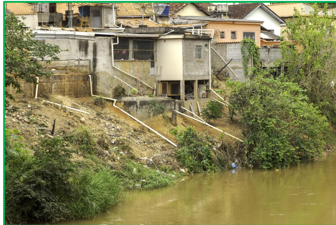
Casas despejando esgoto doméstico diretamente em um rio.
